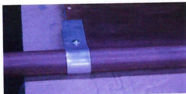
Figura 8.2 União das placas e Abraçadeira
