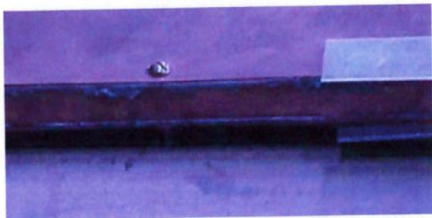
Figura 8.2 União das placas e Abraçadeira
